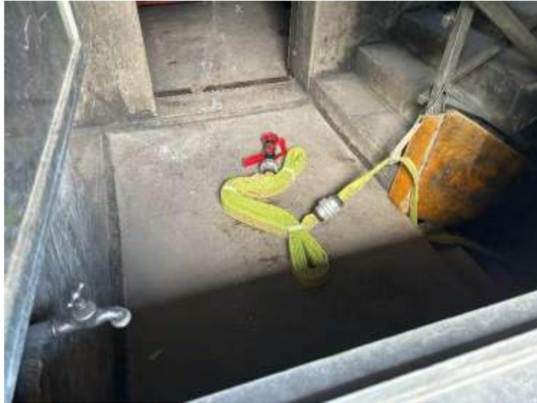
Abb. 7: Sicherung der Schlauchleitung
